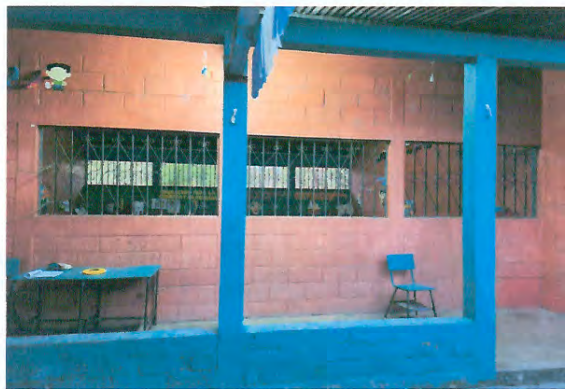
Foto 2: VENTANALES FUERA DEL AULA
