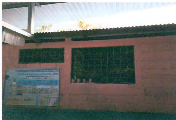
Foto 3: VENTANALES EN EL AREA DE BODEGA
