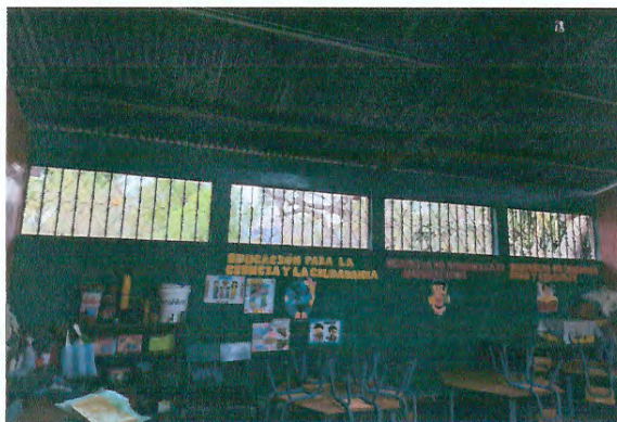
Foto 1: VENTANALES POR DENTRO DEL AULA
